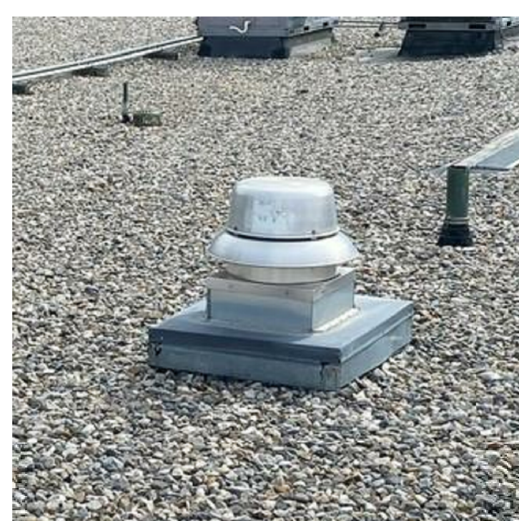
D4 ROOF TOP VENT 7 A532 | SCALE: 3/4" = 1'-0"
