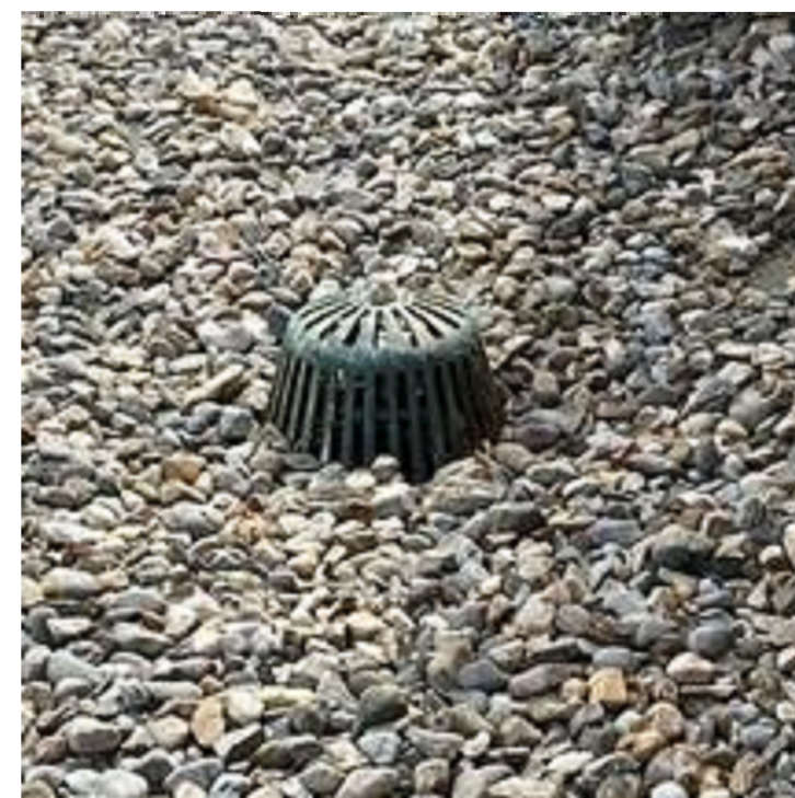
D5 ROOF DRAIN A533 | SCALE: 3/4" = 1'-0"
