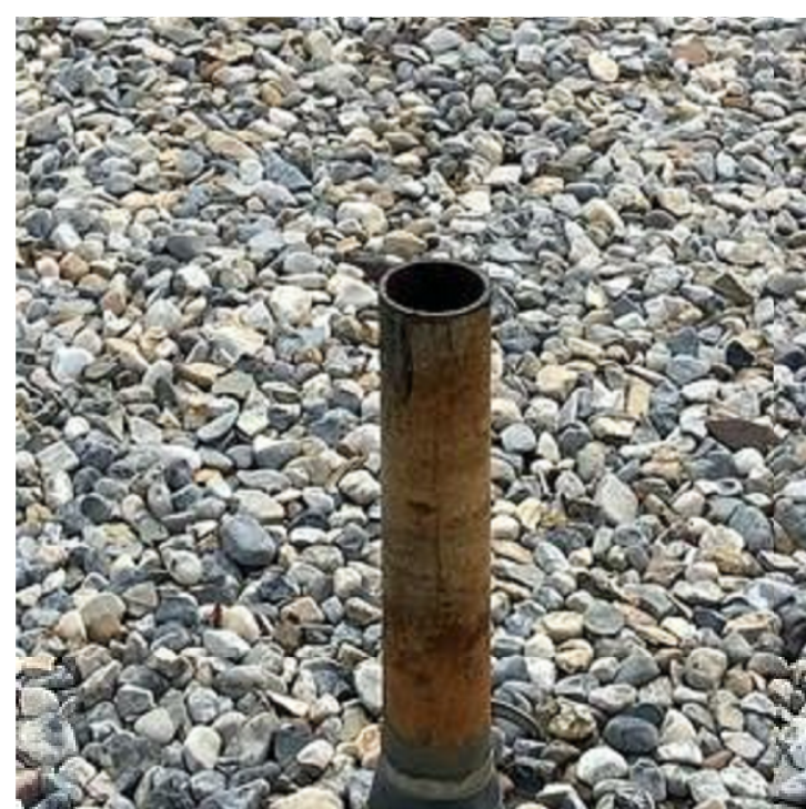
D1 PIPE VENT A533 | SCALE: 3/4" = 1'-0"
